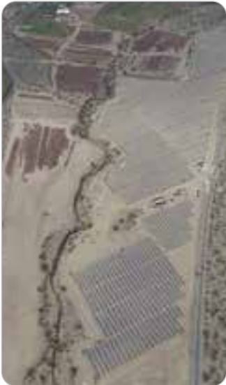
El Jahuel Project Chile | 6.6MW | 2020
