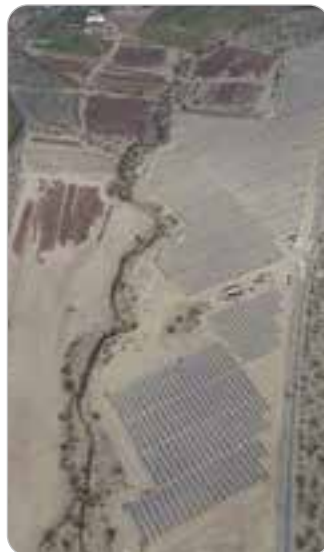
El Jahuel Project Chile | 6.6MW | 2020
